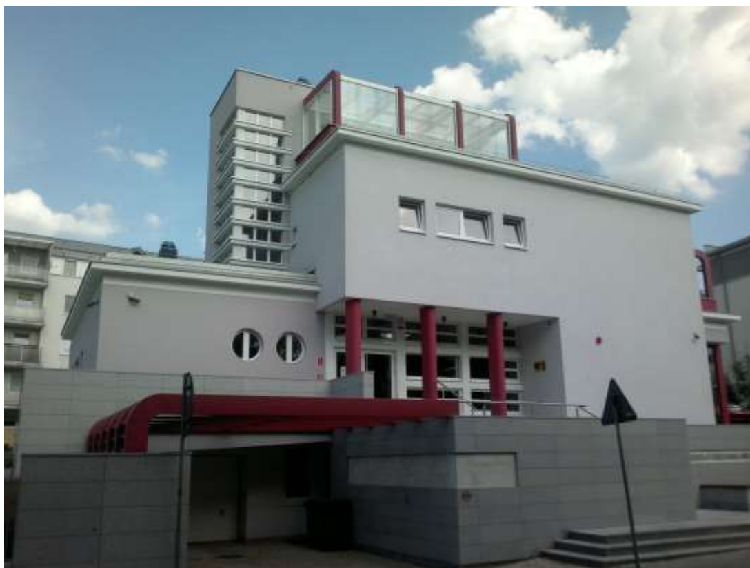
Il. 3. Willa dyrektorska w Mielcu, ul. Chopina 18, elewacja frontowa, fot. autora
