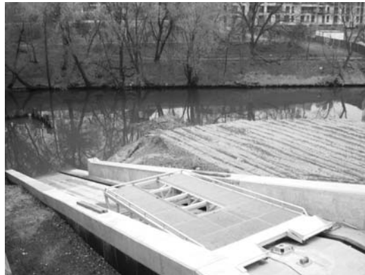
Fot. 7. Budowa slipu w Porcie Praskim
