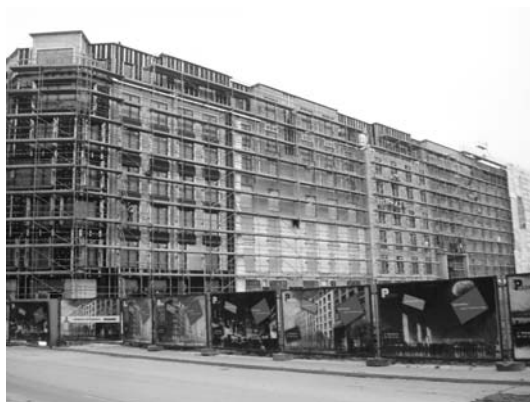
Fot. 6. Port Praski – budynek Sierakowskiego II (w budowie)
