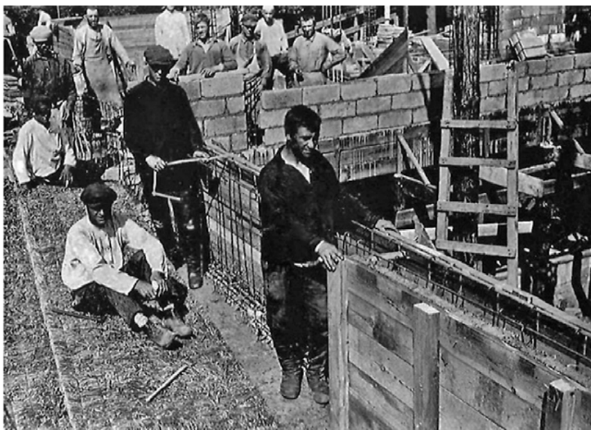
Il. 4. Wykorzystanie bloczków betonowych z otworami do budowania elewacji i stropów w budynku Narkomfinu 1929–1930. Źródło: Archiwum Państwowego Muzeum Architektury (Moskwa)
