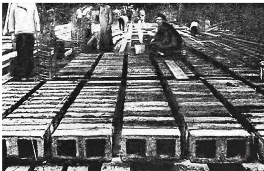
Il. 4. Wykorzystanie bloczków betonowych z otworami do budowania elewacji i stropów w budynku Narkomfinu 1929–1930. Źródło: Archiwum Państwowego Muzeum Architektury (Moskwa)
