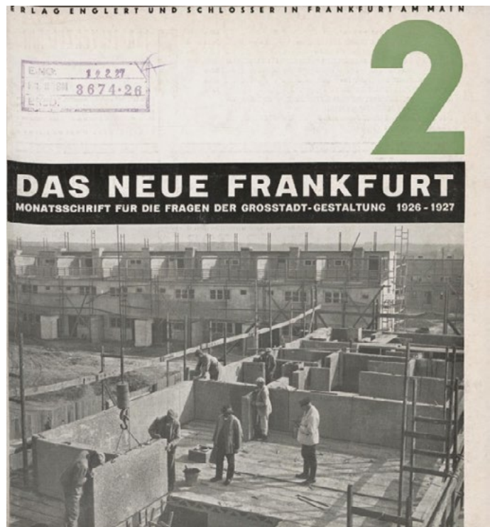
Il. 8. System Maya wykorzystujący żelbetowe panele w siedlung Praunheim, 1926. Okładka drugiego numeru Das Neue Frankfurt . Źródło: Das Neue Frankfurt
