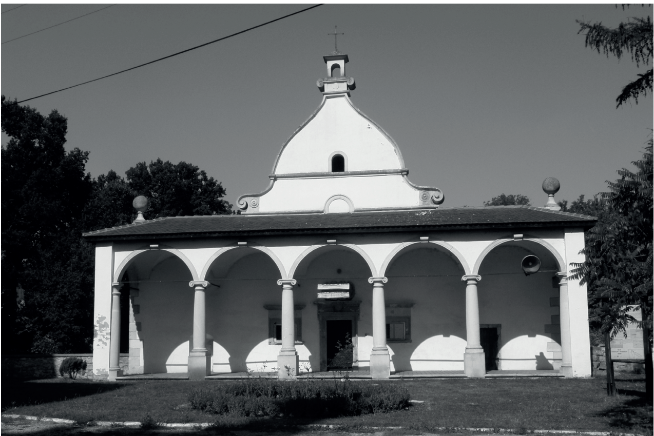
23. Pawilon dawnej kaplicy willi Mirów w Książu Wielkim, fot. A. Stankiewicz
