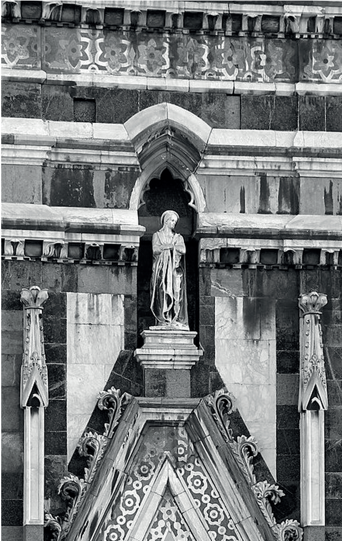
47. Fragment marmurowej okładziny katedry S. Maria del Fiore we Florencji, fot. domena publiczna
