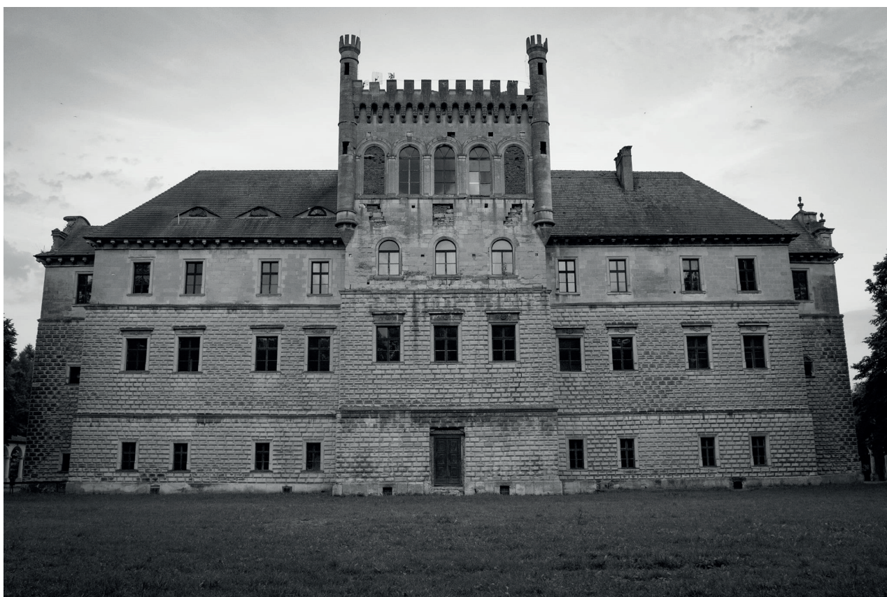
21. Elewacja willi Mirów w Książu Wielkim od strony dawnego ogrodu, fot. A. Stankiewicz
