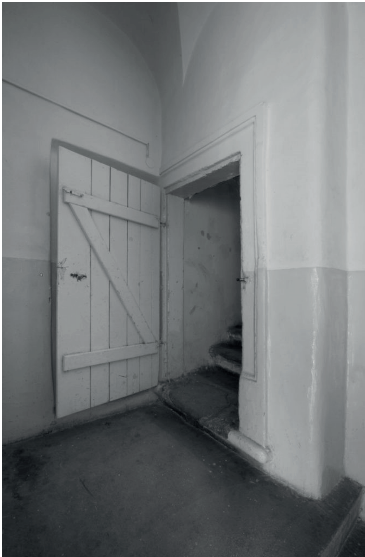
16. Willa Mirów w Książu Wielkim, wejście na klatkę schodową w ryzalicie bocznym, fot. A. Stankiewicz
