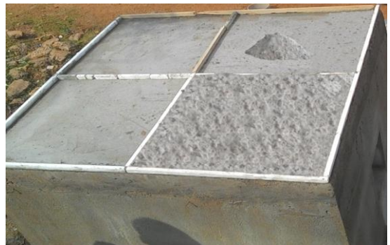
Fig. 8. Fly ash roof slab.
