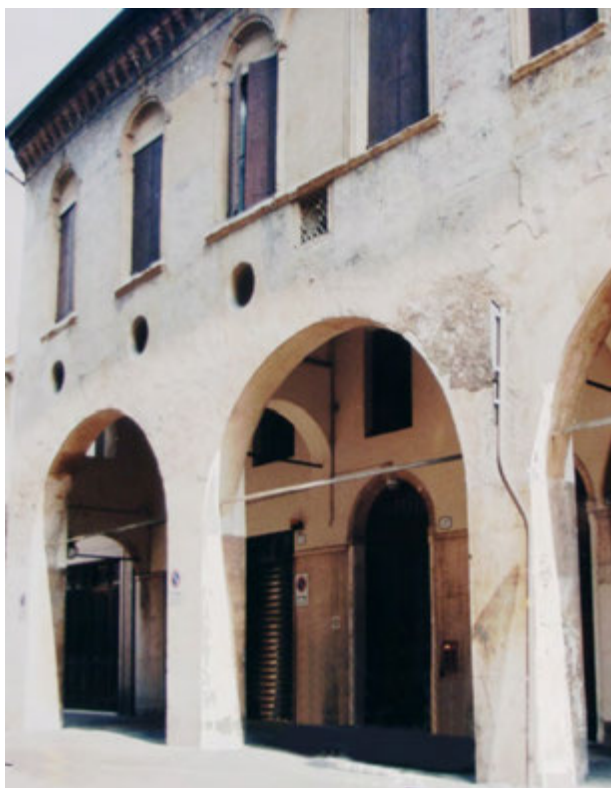
24. Padwa, domy podcieniowe przy ul. Cesare Battisti 125–129 24. Padova, palazzi signorili con portic in Via Cesare Battisti 125–129
