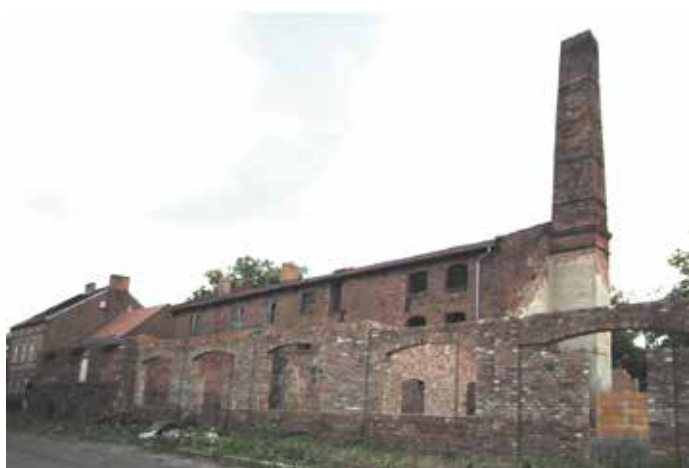
Fot. 2. Odbudowywana gorzelnia w Grobi – jedyna pozostałość zespołu rezydencjonalno-folwarcznego Fot. M. Szczepańska (fot. 2 i 3).
