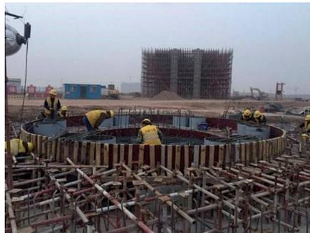
(d) Steel pipe supporting foot construction
